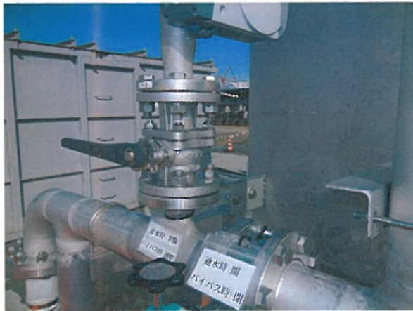
脱塩器入口ライン入口弁廻り
