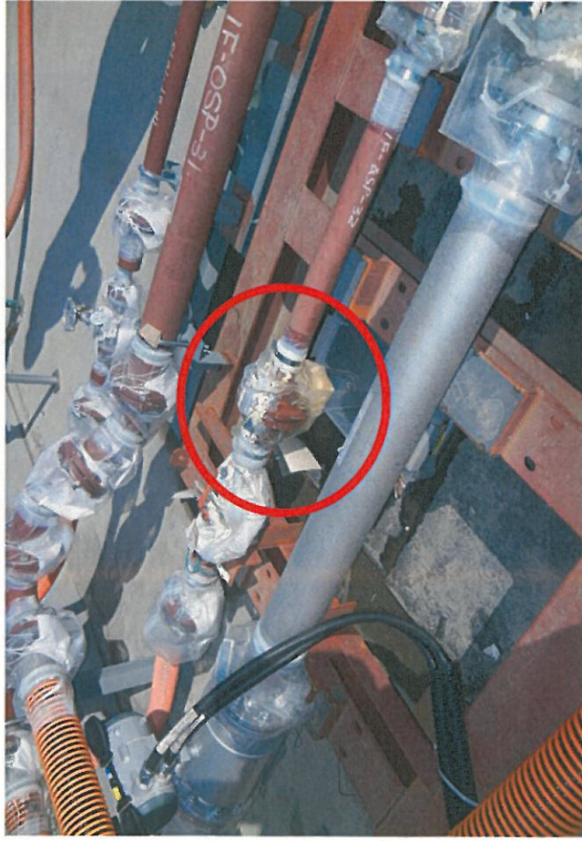
廃液供給ポンプ(B)ミニマムフローライン部
