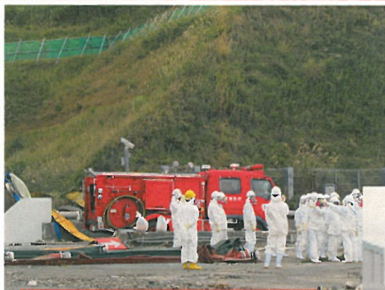
消防車（加圧ポンプ）配置 及び 現場ミーティング
