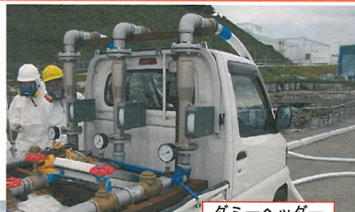
ダミーヘッダー を通しての注水 （海への放水）
