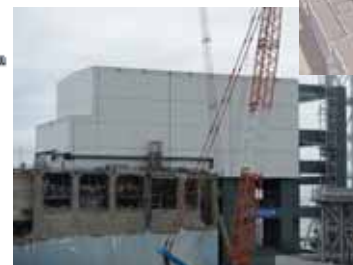
屋根・外壁設置(南西面)
