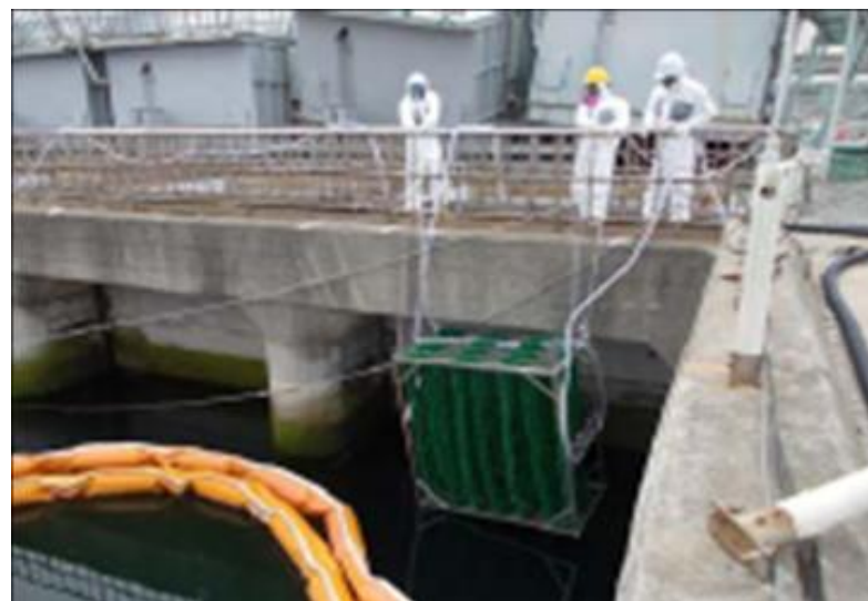
現場での装置設置状況
