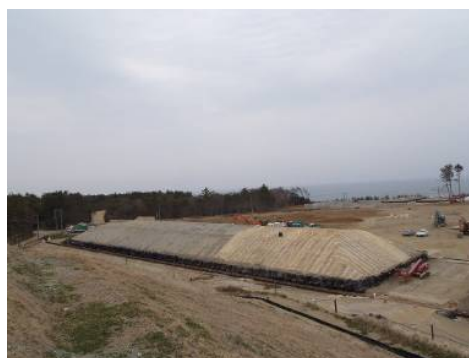
2槽目の状況 (3/25撮影)
