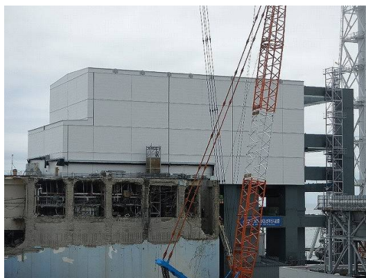
燃料取り出し用カバーの外壁
