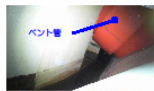
ベント管下部の撮影写真(H25/3/13撮影)
