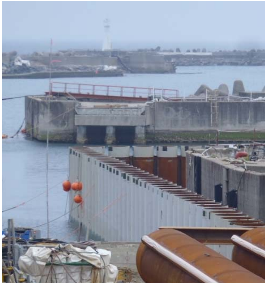
1～4号機取水口北側の状況
