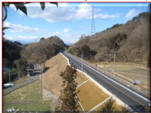
国道459号西新殿バイパス(二本松市)
