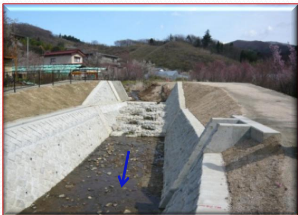
通常砂防事業 ・くるみ沢(福島市)
