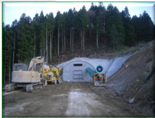
国道114号小綱木バイパス(川俣町)小綱木トンネル
