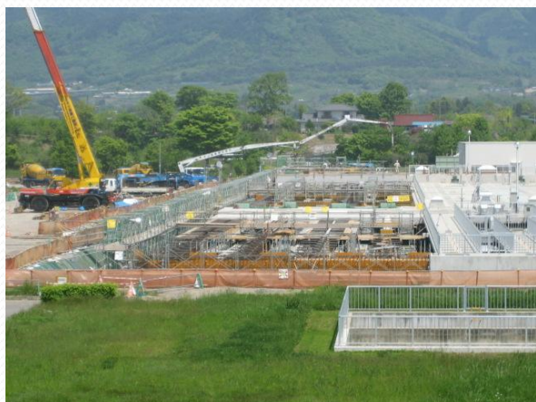
県北浄化センター
