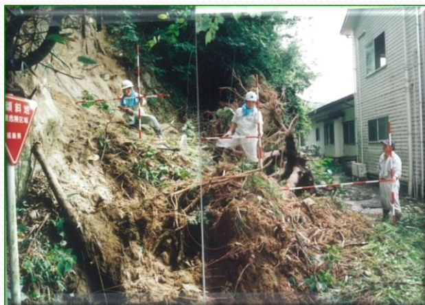
急傾斜地対策事業 ・上ノ台(川俣町)
