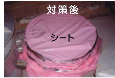
ベント管の開口部分 混入ルートと推測されるルートを塞ぎました
