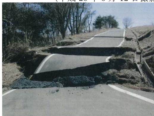
写真 2-12 農道の被災状況
