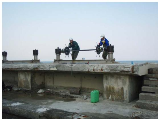
写真 2-34 手動でのゲート開閉作業
