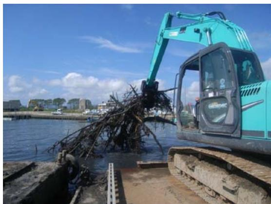
写真 2-77 漁場堆積物除去状況（松川浦）
