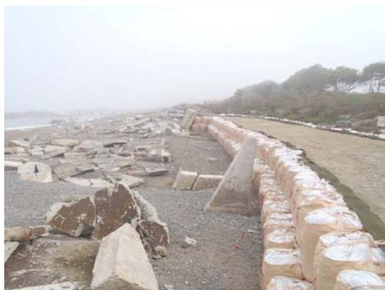
写真 2-40 仮締切工事実施後
