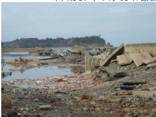
写真 2-13 津波により破堤した海岸堤防
