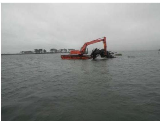
写真 2-78 漁場堆積物除去状況（松川浦）
