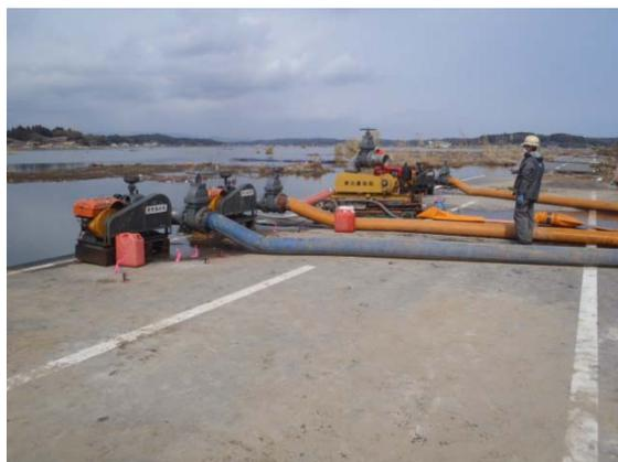
写真 2-33 ポンプによる排水状況
