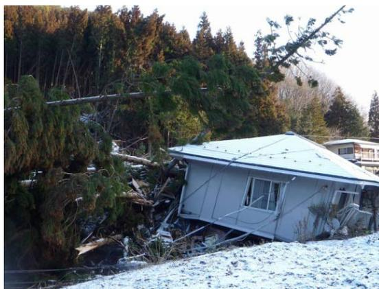
写真 2-1 山腹崩壊に伴う住宅被害
