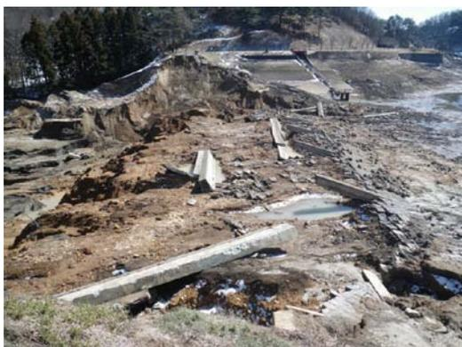
写真 2-9 地震により決壊したため池
