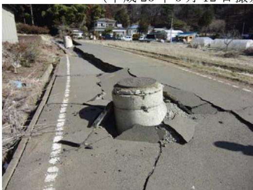
写真 2-11 地震により浮上した農業集落排水施設用マンホール
