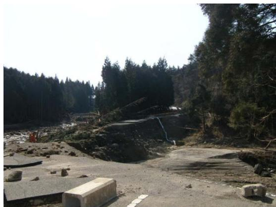
写真 2-18 地震により被災した林道戸渡藤沼線
