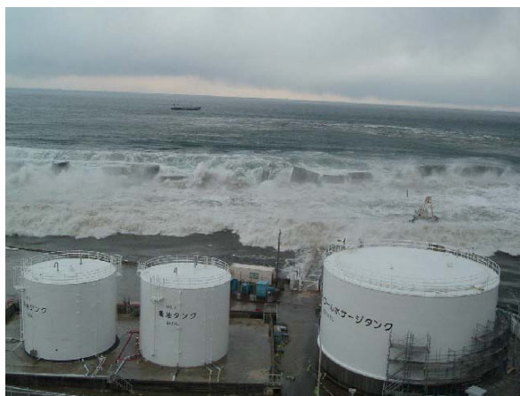
写真 1-8 第一原子力発電所 (平成23年3月11日撮影)
