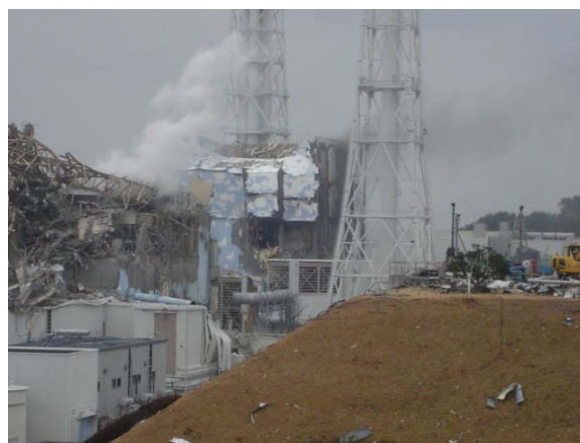
写真 1-11 事故後の 3 号機と 4 号機 (平成 23 年 3 月 15 日撮影)
