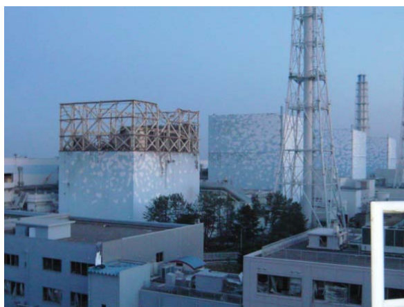
写真 1-10 事故後の 1 号機 (平成 23 年 3 月 12 日撮影)
